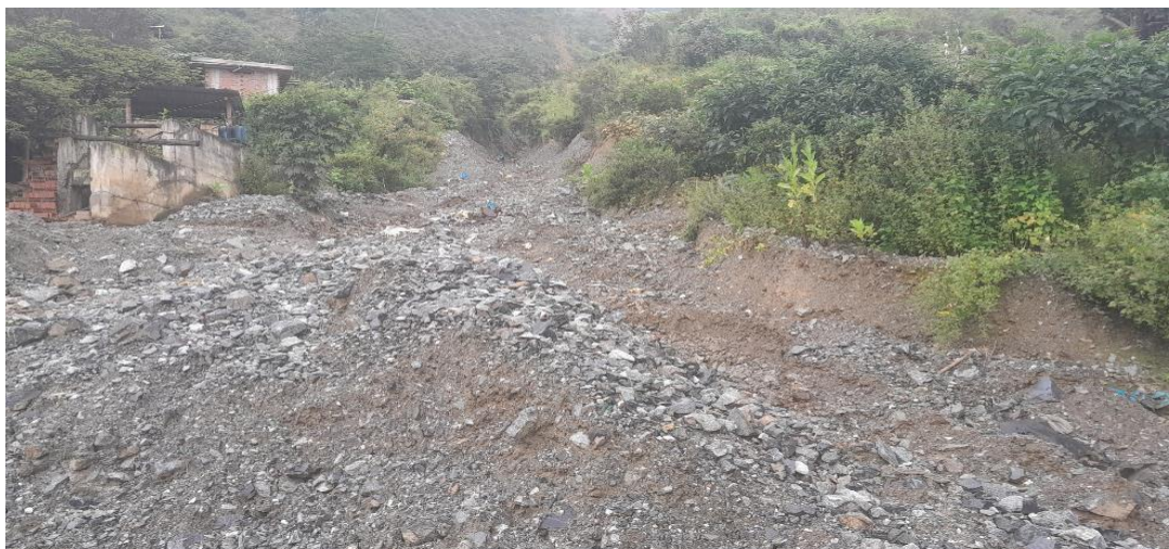
IMAGEN N°02: Se observa la colmatacion en la quebrada las Naranjas requiere de mantenimiento del cauce
